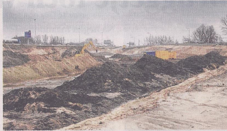
De werkzaamheden aan de randweg, hier bij de Poot van Metz, zijn momenteel in volle gang. foto Jurriaan Balke
